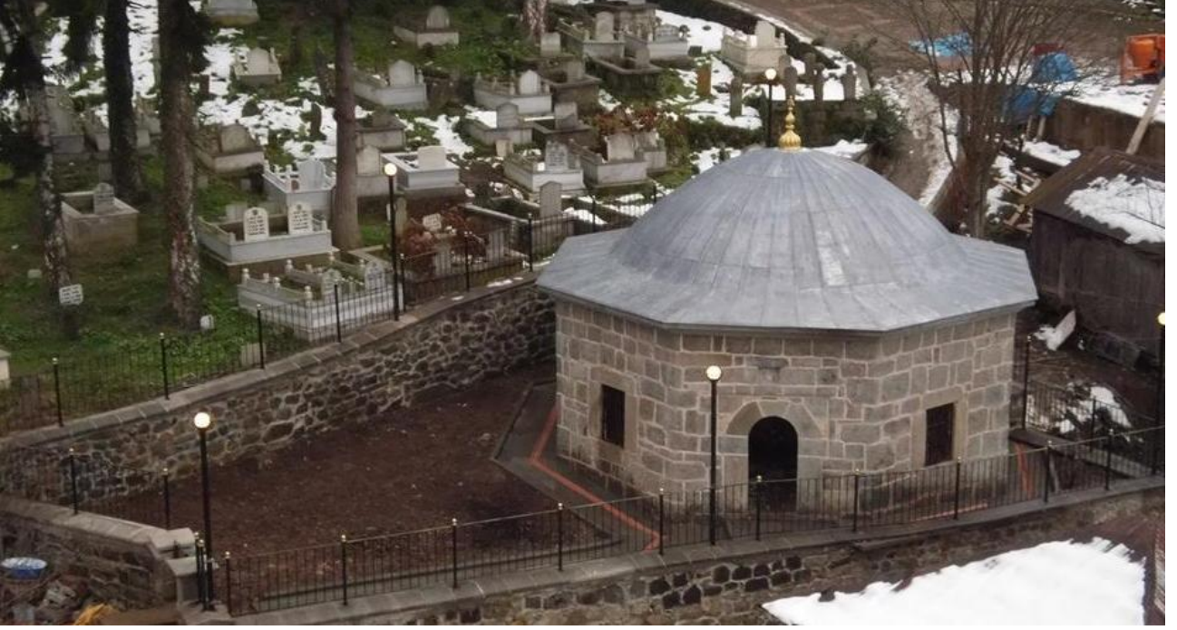
Fotoğraf-3: Onarımı Tamamlanan Yakup Halife Türbesi
